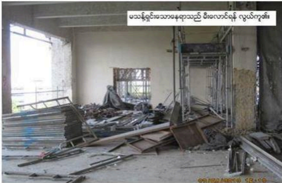
ပုံ ၂ - ၇။ မီးဘေးအန္တရာယ်ကို ကာကွယ်ရေးအတွက် အရေးကြီးဆုံးအရာမှာ လုပ်ငန်းခွင်ကို သန့်ရှင်းစွာထားရေးဖြစ်၏။
